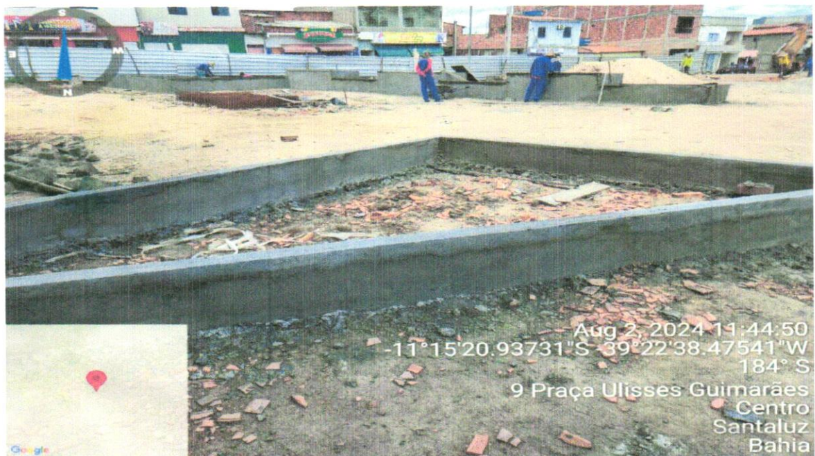
FOTO 30 – EXECUÇÃO DA ALVENARIA DO ESTACIONAMNETO
