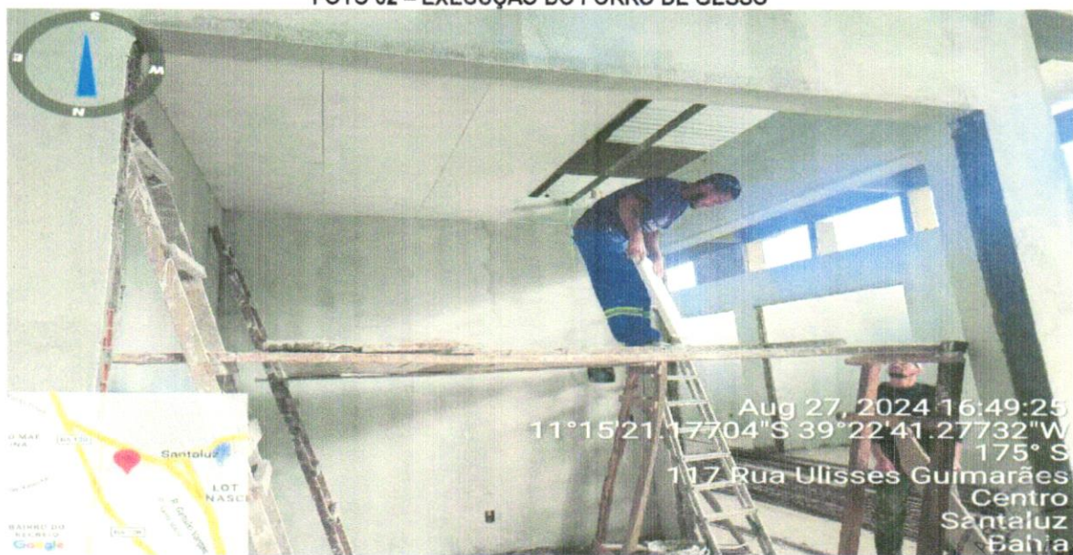
FOTO 02 – EXECUÇÃO DO FORRO DE GESSO
