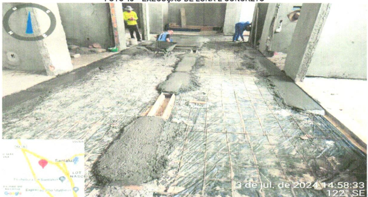
FOTO 18 – EXECUÇÃO DE LONA E CONCRETO
