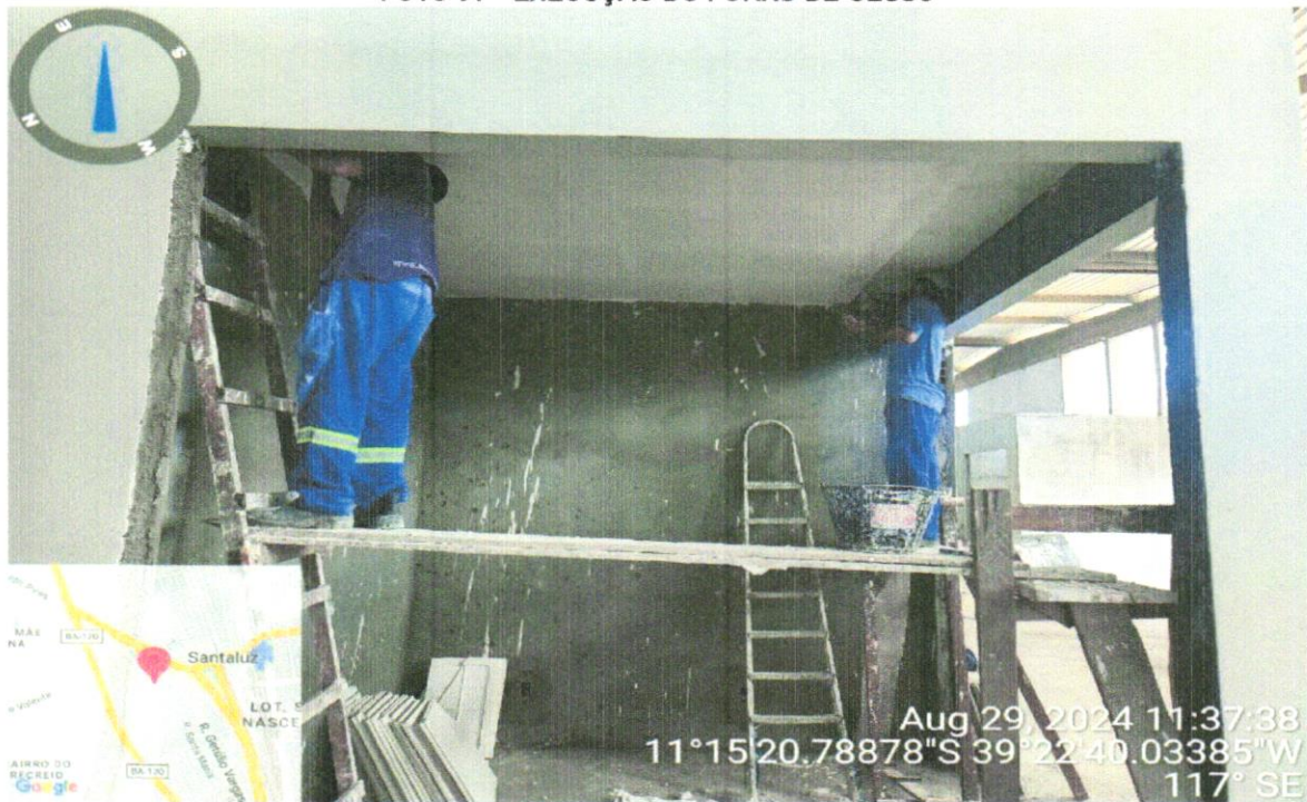
FOTO 02 – EXECUÇÃO DO FORRO DE GESSO
