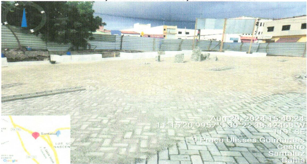
FOTO 26 – APLICAÇÃO DE SELADOR E EXECUÇÃO DE INTERTRAVADO
