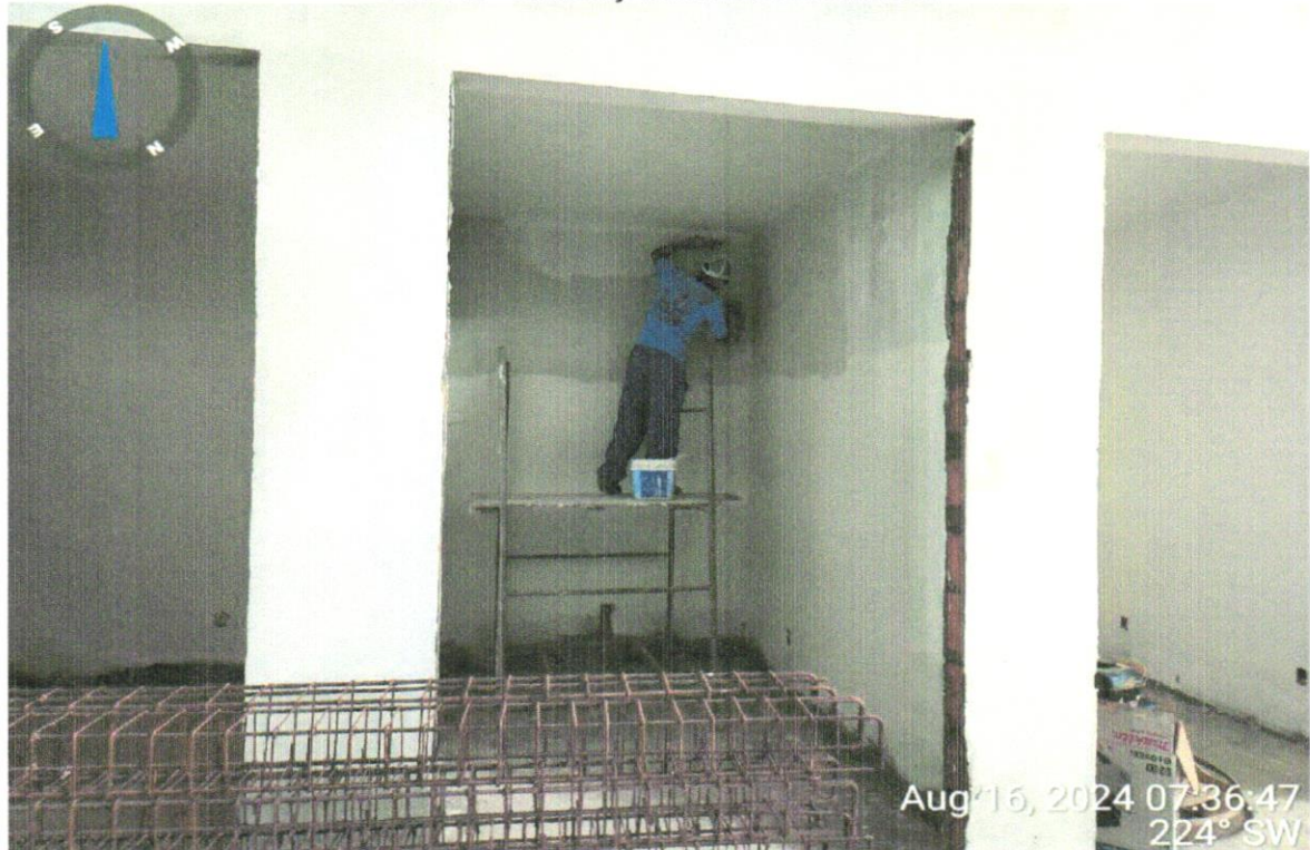
FOTO 08 – APLICAÇÃO DE MASSA ACRÍLICA
