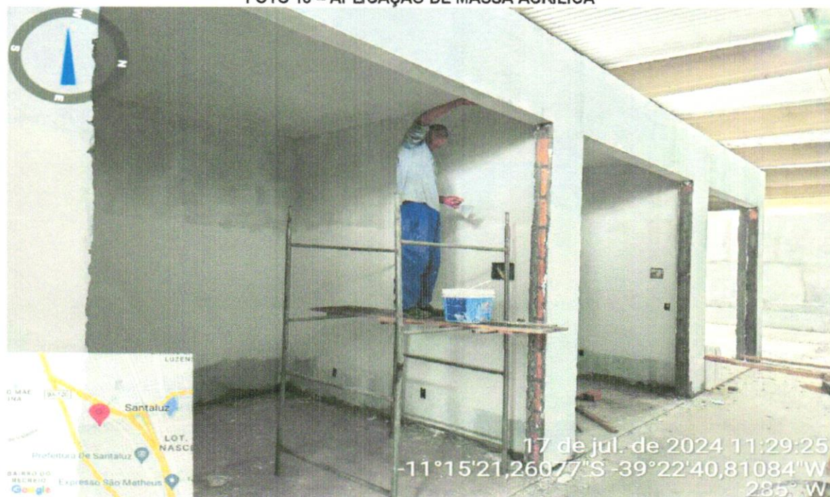
FOTO 16 – APLICAÇÃO DE MASSA ACRÍLICA
