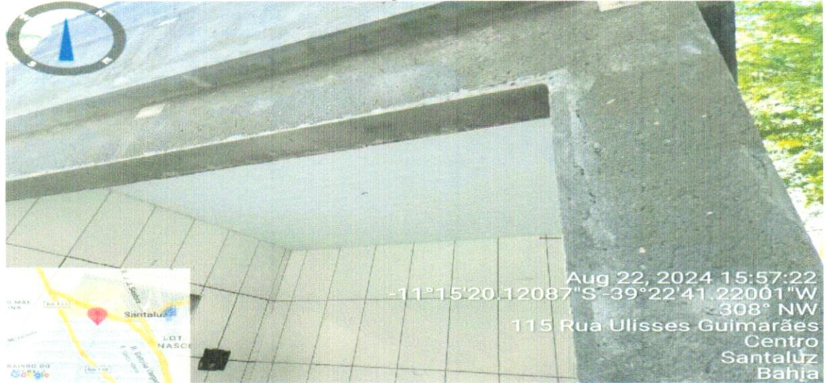
FOTO 12 – EXECUÇÃO DO FORRO DE PVC
